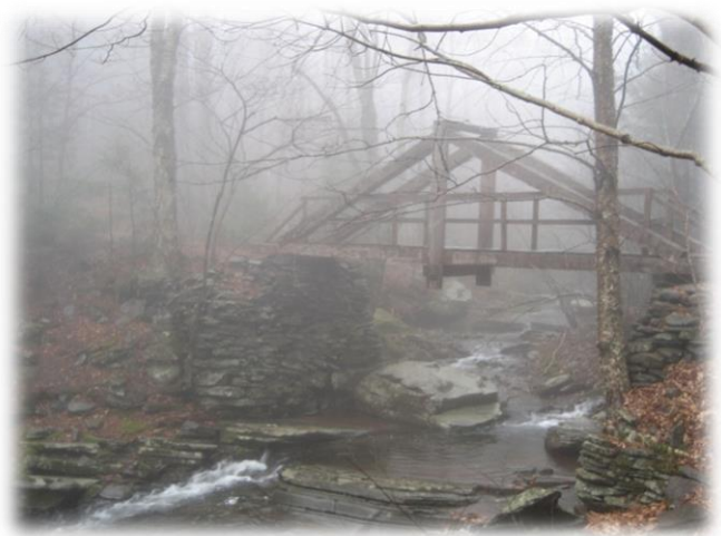
Platte Kill footbridge
